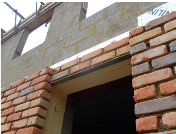
Isolant : 12 + 10 cm (PIR, PUR...) – (© R.Betz)
