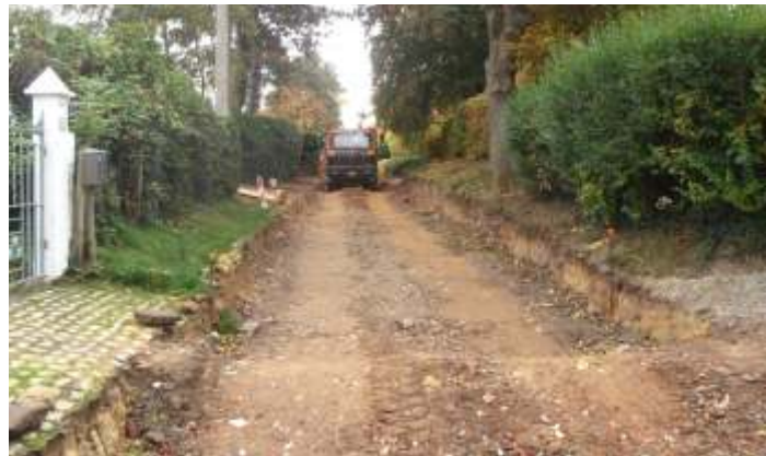
Egouttage rue de Moriensart
